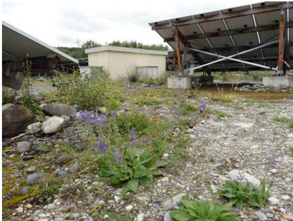
La centrale SIG Solar
